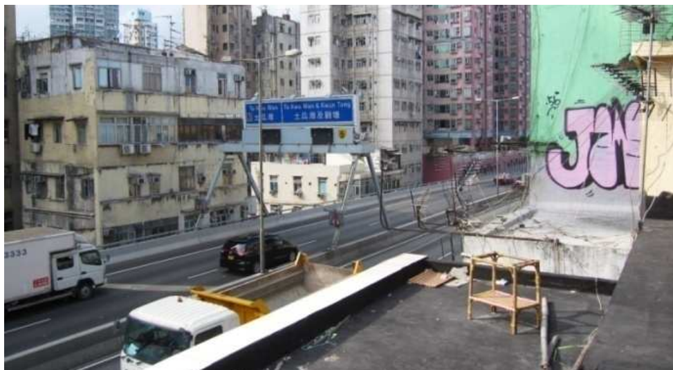
图 14：东九龙走廊天桥与民居非常接近（近九龙城道一带）
